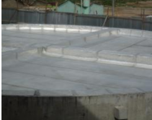
Nueva impermeabilización en cubiertas efectuada bajo el contrato 1993 de 2010
