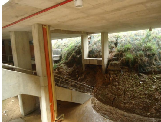
SE ENCUENTRA MAYOR MATERIAL DEPOSITADO POR EL DESLIZAMIENTO ORIGINAL DEL FALLO AUMENTANDO EL RIESGO QUE COMPROMETE LA ESTRUCTURA EN EL BLOQUE C Y D
