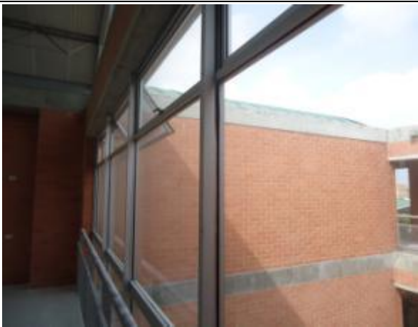
Refuerzo realizado a la estructura de la ventanería
