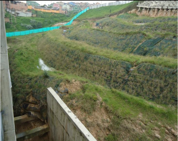
DESLIZAMIENTO DE TRATAMIENTO DE TIERRAS ARMADAS
