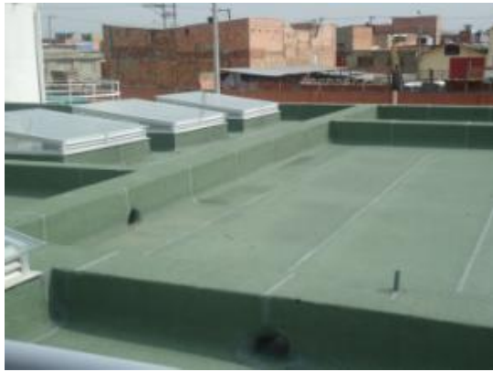
Nueva impermeabilización en cubiertas efectuada bajo el contrato 1993 de 2010
