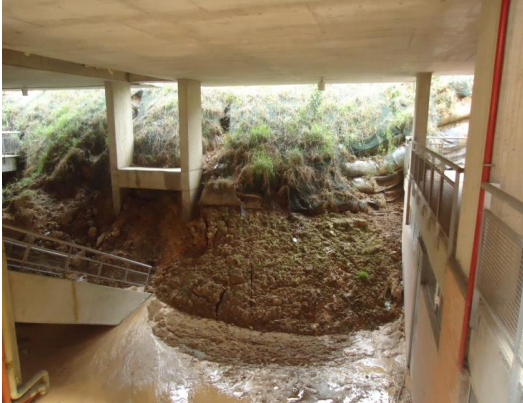
SE ENCUENTRA MAYOR MATERIAL DEPOSITADO POR EL DESLIZAMIENTO ORIGINAL DEL FALLO AUMENTANDO EL RIESGO QUE COMPROMETE LA ESTRUCTURA EN EL BLOQUE C Y D
