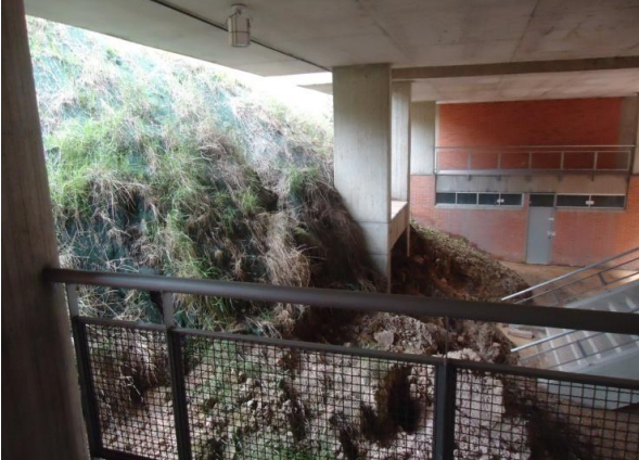
EL DESLIZAMIENTO Y LA EMERGENCIA PRESENTADA ESTA COMPROMIETIENDO LA EDIFICACIÓN DEL COLEGIO EXISTENTE
